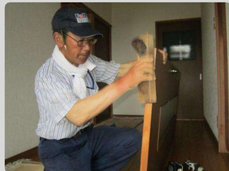
家屋修理ボランティア 戸の建付けの調整
